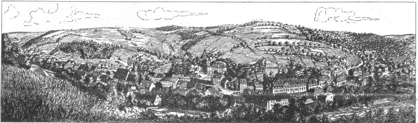
Aufnahme von der Südseite
